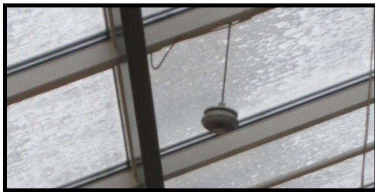
Figur 2.10 Bilden visar en av gångstråkens hängande rökdetektorer.
