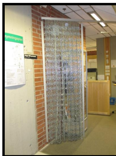
Figur 9.2 Exempel på skjutbar gallergrind.
