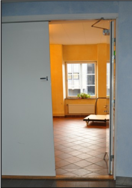
Bild 13.1. Befintlig dörruppställare mot trapphus E från Wirénsalen (Foto: Daniel Lillienberg).
