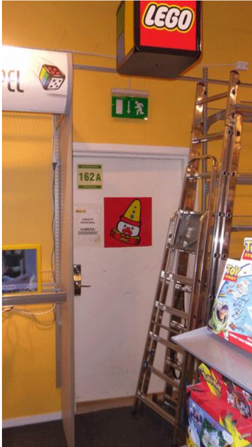
Figur 9. Den 92cm smala utrymningsvägen, blockerad av stegar, längst bak i Lekia på plan 1.
