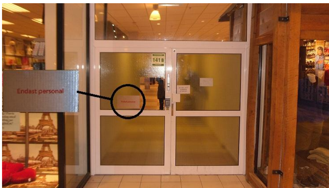
Figur 34. Låst och dåligt markerad utrymningsväg mellan Femman sport och Gallerix på plan 1.
