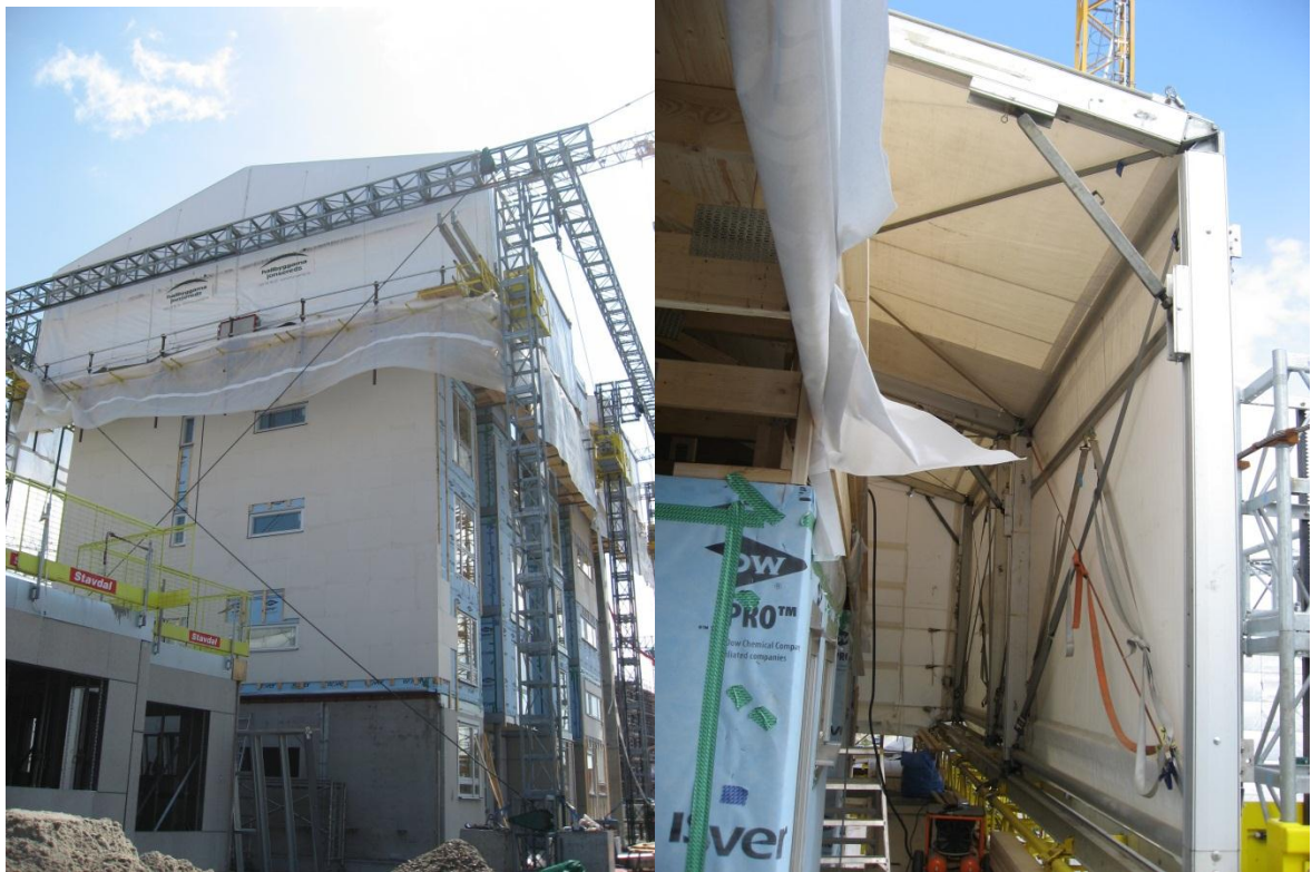
Bild. 5.4 och 5.5 Väderskydd som skyddar byggnaderna i Västra Hamnen i Malmö
