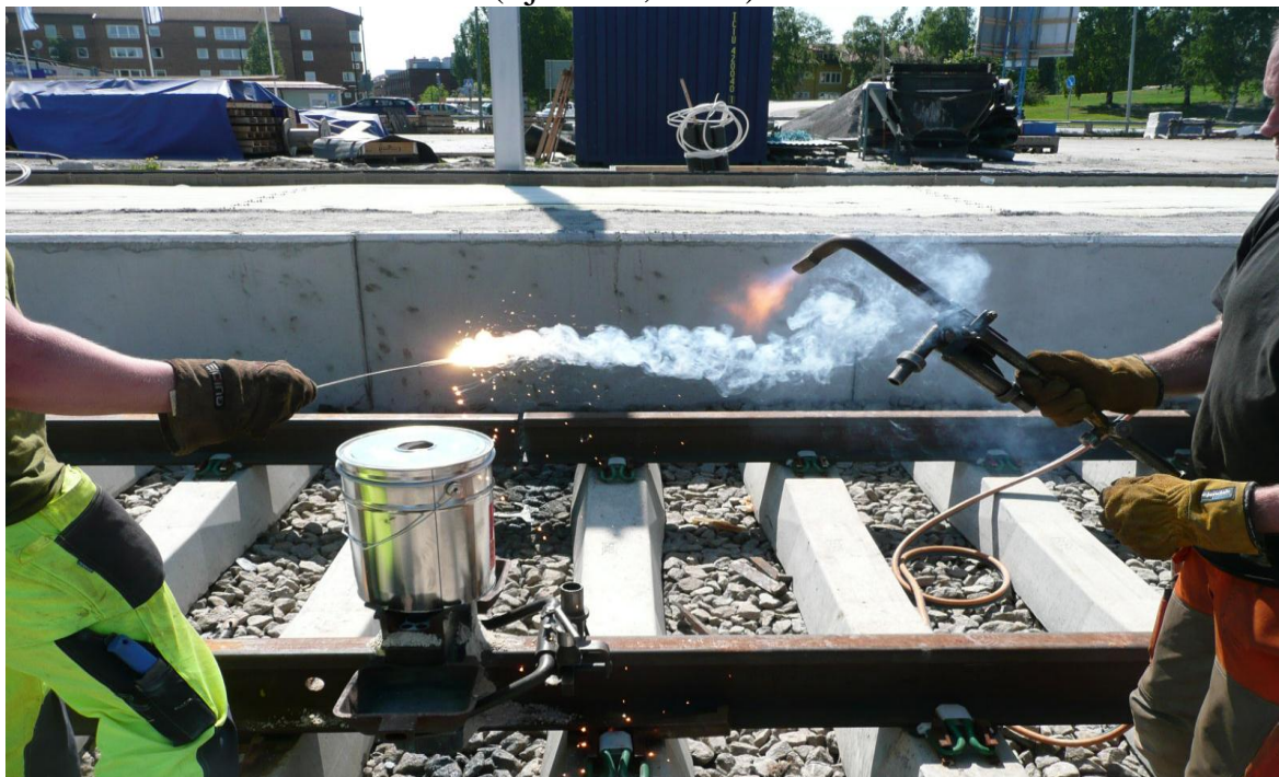
Figur 2 Tändning av aluminiumoxidblandning (Aron Östlund)
