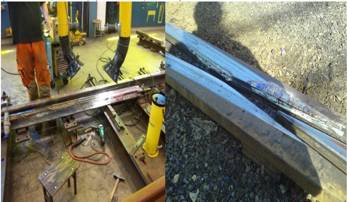
Figur 5 påsvetsning av tunga och korsning (Henrik Svensson)
