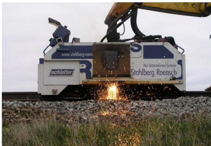
Figur 4 Mobilt brännsvetsaggregat svetsning i fält (Henrik Svensson)
