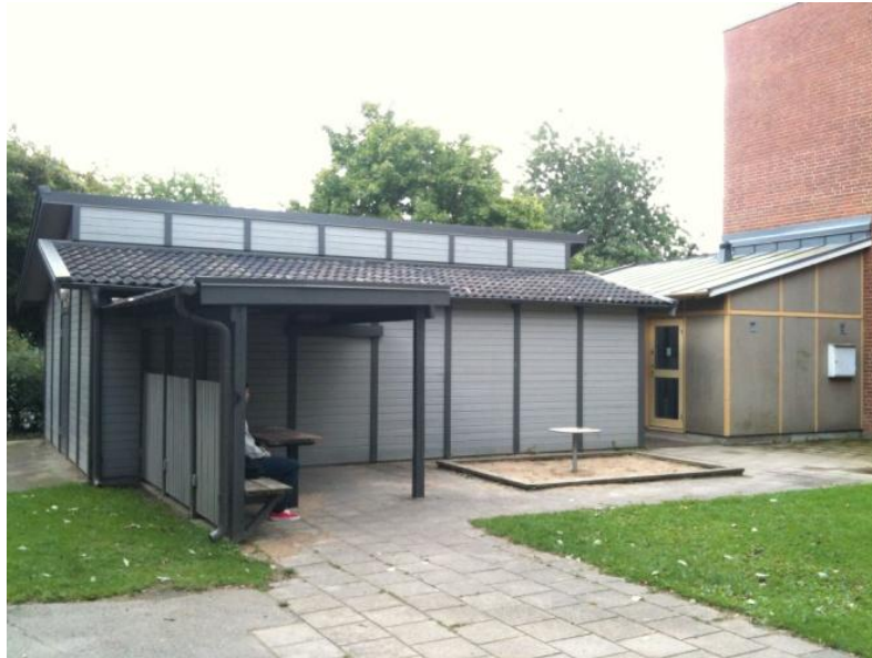
Figur 8 Tillbyggda förråd och tvättstugor mellan husens kortsidor
