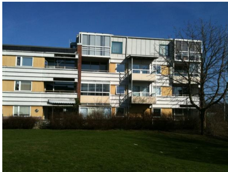
Figur 21 Påbyggnaden från baksidan där de extra balkongerna syns
