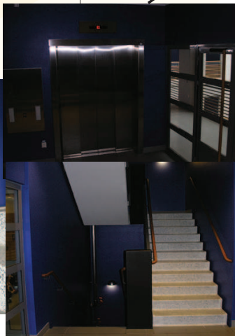
Hiss och trappa i trapphusen
