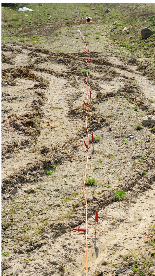
Fig. 5. Bild med elektroder anslutna via jumpers till kabel med 2 m elektrodavstånd. Kabeln ansluts till mätutrustningen längst upp i bilden (se fig. 6.). Vid första och sista mätningen används tre uppsättningar kablar och vid övriga mätningar används fyra kablar (se fig. 7.).
