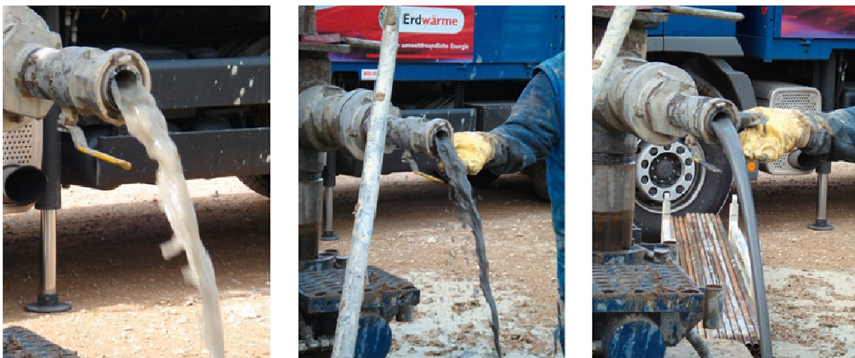
Fig. 6: Inspektion av material som pressas ut ur borrhålet under återfyllning från botten och upp. Bilden är hämtad från ett faktablad om produkten ThermoCem Plus som tillverkas av HeidelbergCement.
