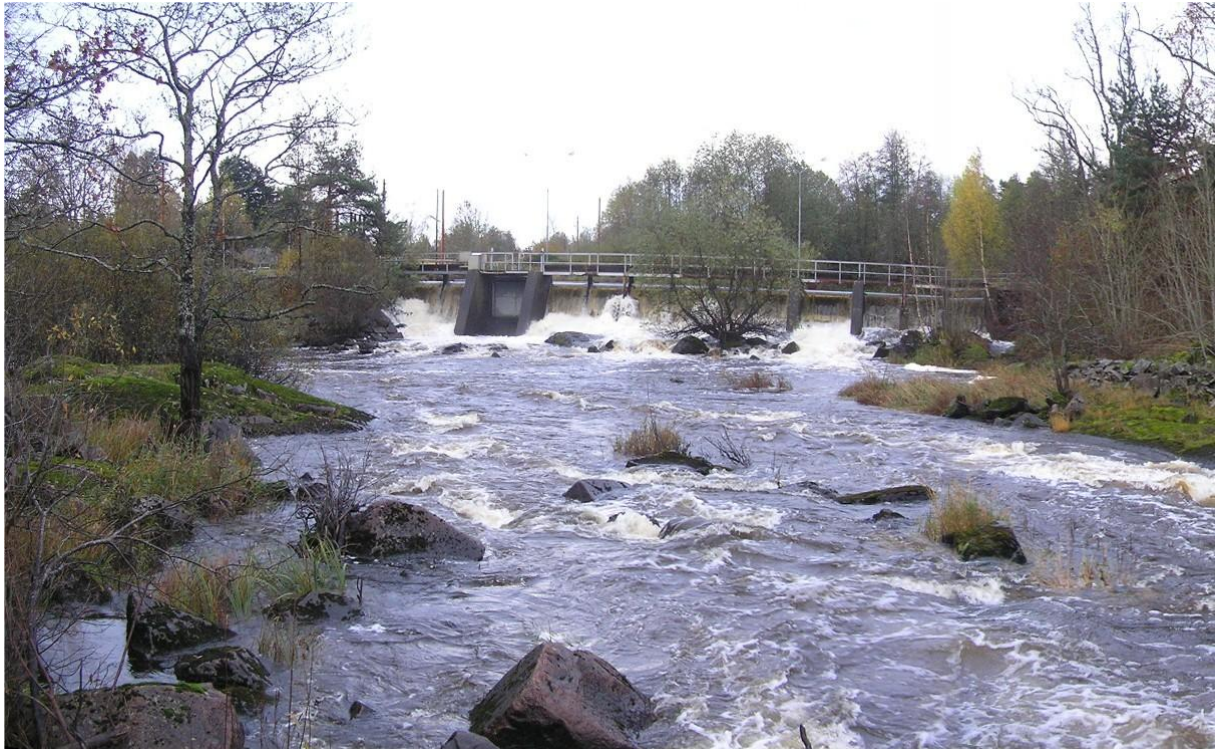
Figur 2-6 Nedströms vy av dammdel 2.
