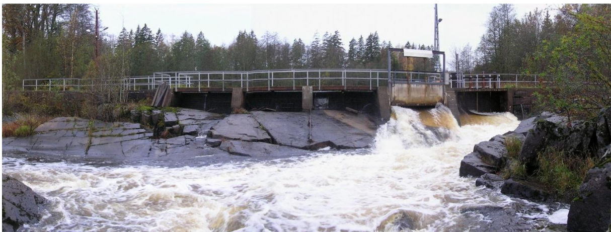
Figur 2-5 Nedströms vy av dammdel 1.
