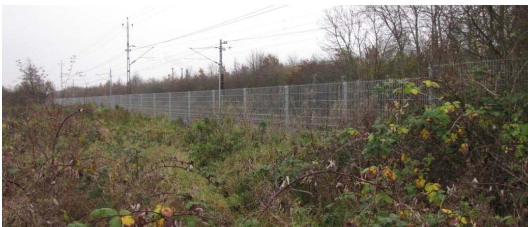
Bild 6: Visar stängsel vid södra Lund som installerades under 2010
