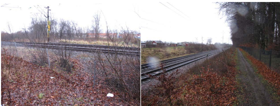
Bild 3: Bandel 912 vid kilometerskyt 584+690 (till vänster) och 585+100 (till höger)
