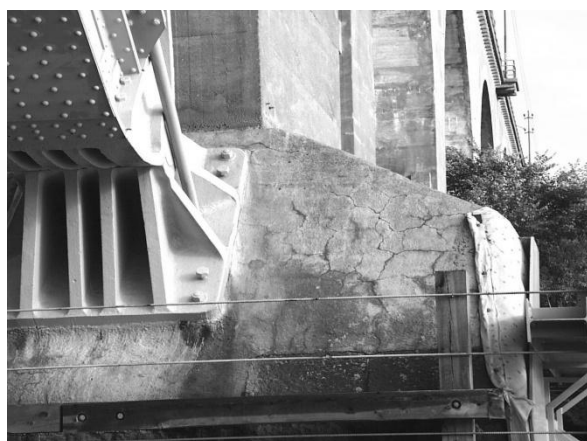
Figur 6. Fundamenten är uppspruckna pga. inre frostsprängning (Fridh, 2012)
