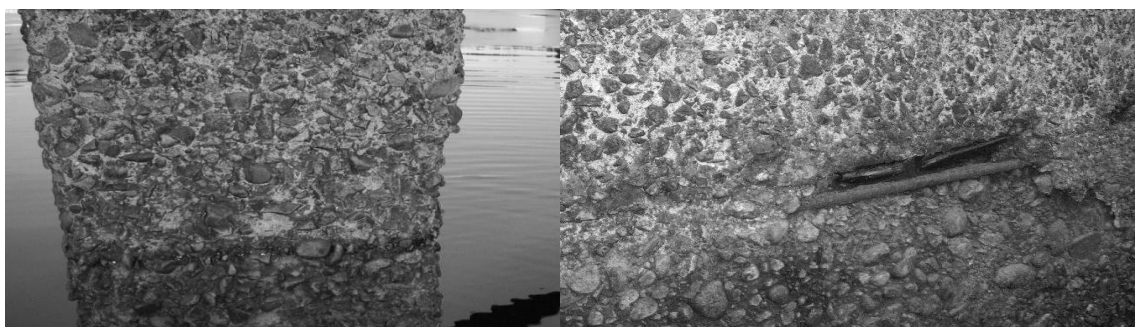
Figur 4. Vattenkraftsanläggning i Luleå-älven. Stora avskalningar som till slut frilägger armeringen (Persson & Rosenqvist, 2009)
