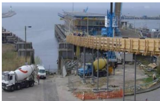
Figur 23. Gångbro, Sassnitz (Sika, 2012b)
