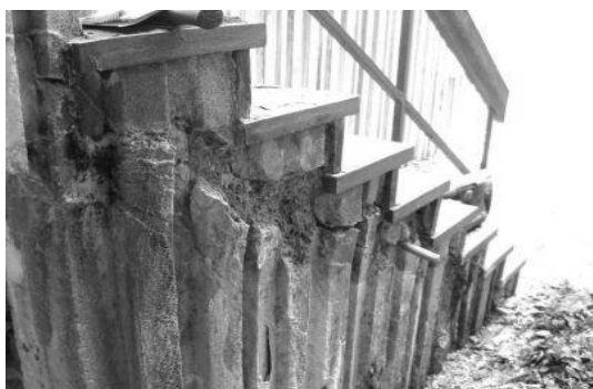
Figur 2. Frostangrepp hos en betongtrapp. (Stockholm Betongkonsult AB, 2009)
