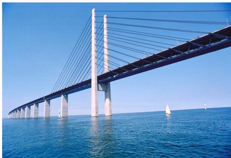
Figur 25. Öresundsbron. Foto: Pierre Mens / Øresundsbron
