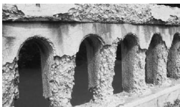
Figur 3. Frostangrepp hos en betongkonstruktion. (PCA, 1998)
