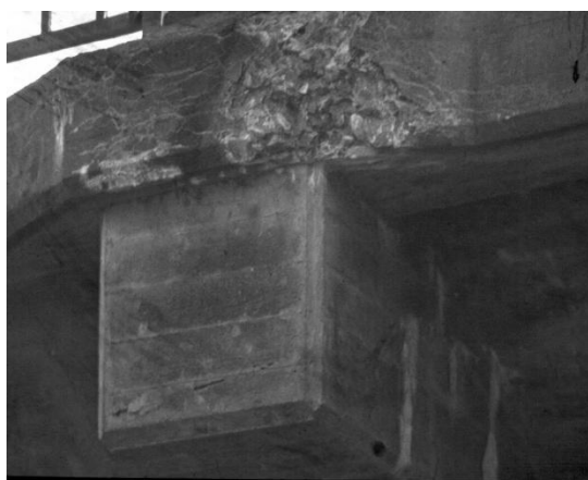
Figur 5. Vatten (och salt) från vägbanan rinner ner på kantbalken och orsakar ytavskalning (Fridh, 2012)
