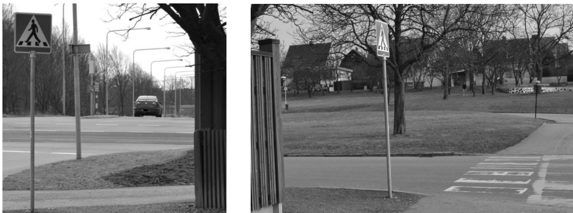
Figur 13 Dålig sikt i korsning med Viskgatan. T.v. syns den slitna gulmarkeringen (Foto: Emilia Bengtsson)
