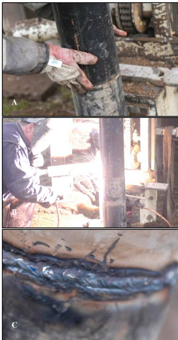
Foto 1A. Placering av foderrör innan svetsning vid energi-brunnen i Helsingborg. Foto 1B. Svetsning av foderrör i Helsingborg. Foto 1C. Svetsfog på foderröret vid energi-brunnen i Helsingborg (Foto av Jari Leskelä 2012).
