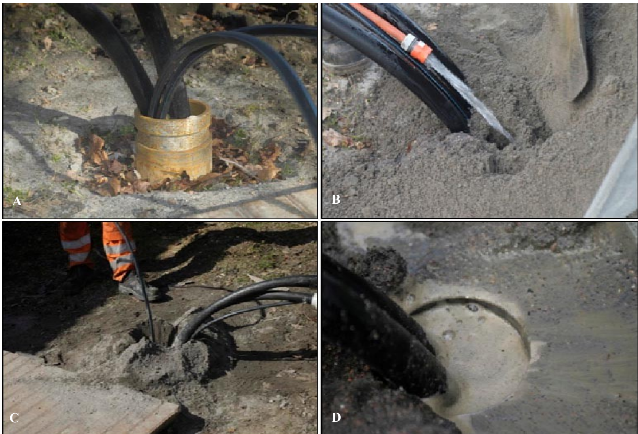
Foto. 5A. Borrhål med installerad kollektorslang och slangar för täthetsmätning. Foto. 5B. Återfyllning dag 1 med vatten. Foto. 5C. Nedfösning av stenmjöl i borrhål med fötter. Foto. 5D. Stopp i borrhål under återfyllning. (Foto av Jari Leskelä 2012).
