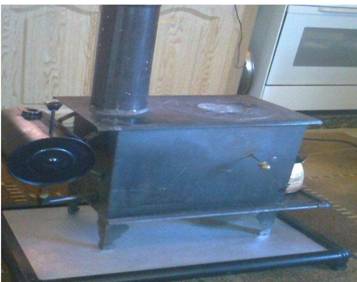
Figur 4.6 Det oljedrivna värmesystemet.
