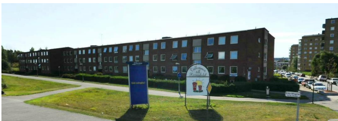
Östra fasaden av fastigheten Docenten 8
