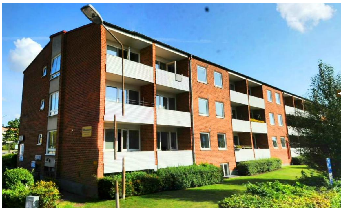
Västra fasaden av fastigheten Docenten 8
