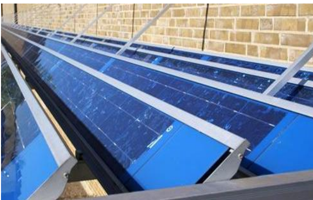
Utvändig solavskärmning med integrerade solceller.
