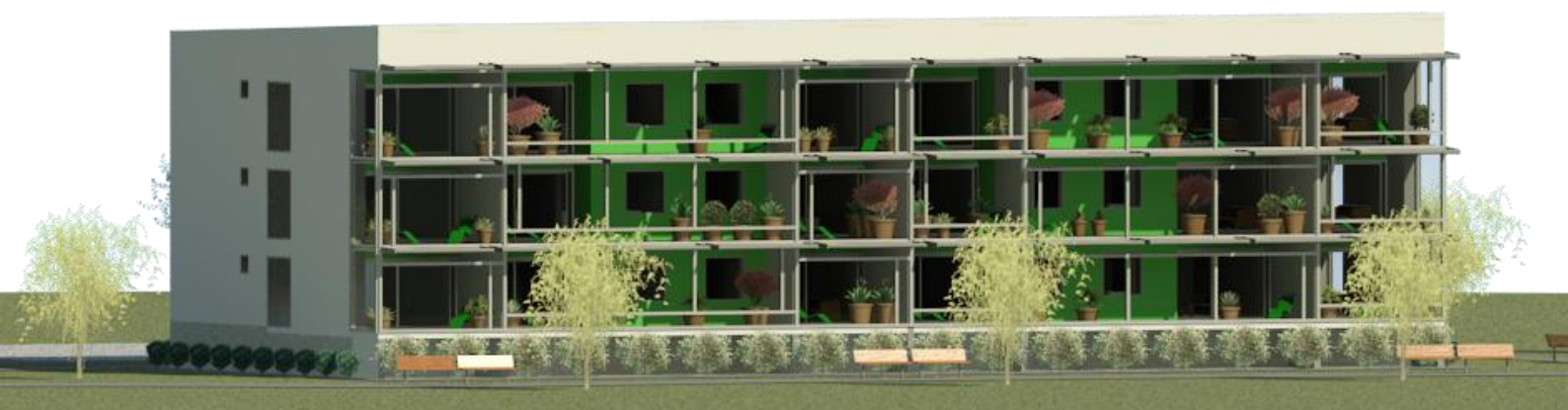
Västra fasaden av fastigheten Docenten 8
