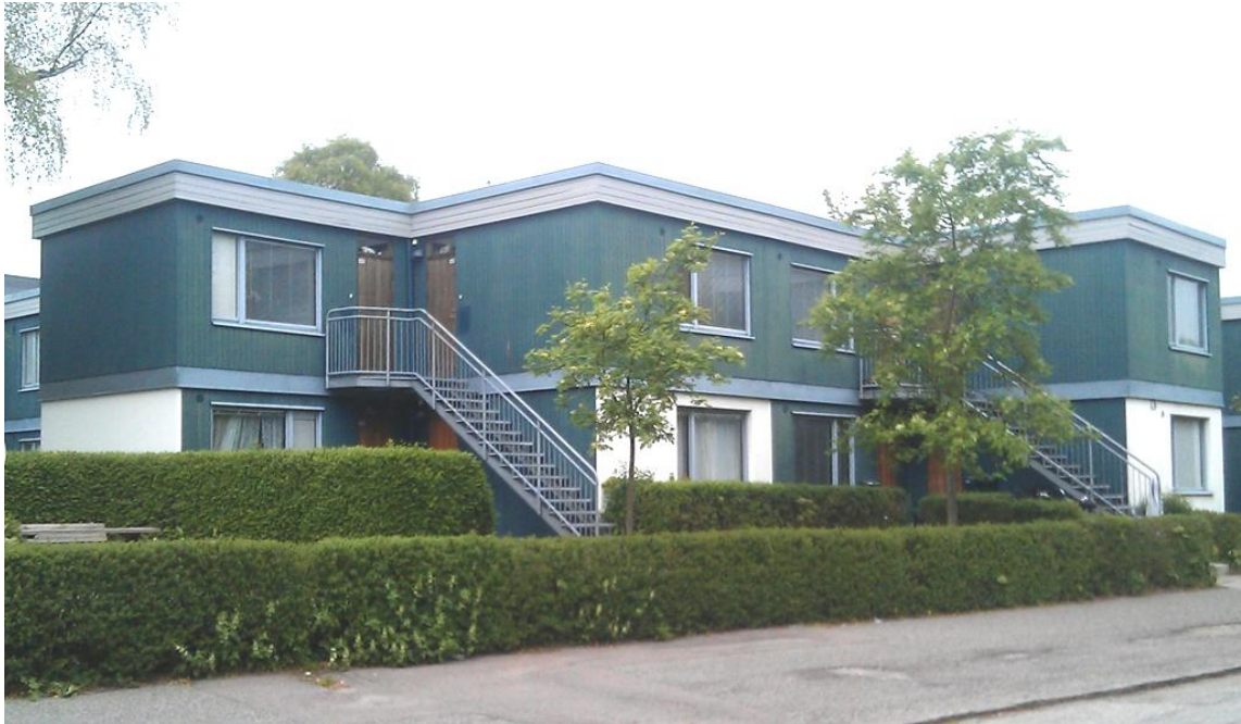
Bild 1. Fyrklöverhus på Gylleholm, där flera enheter är hopbyggda.
