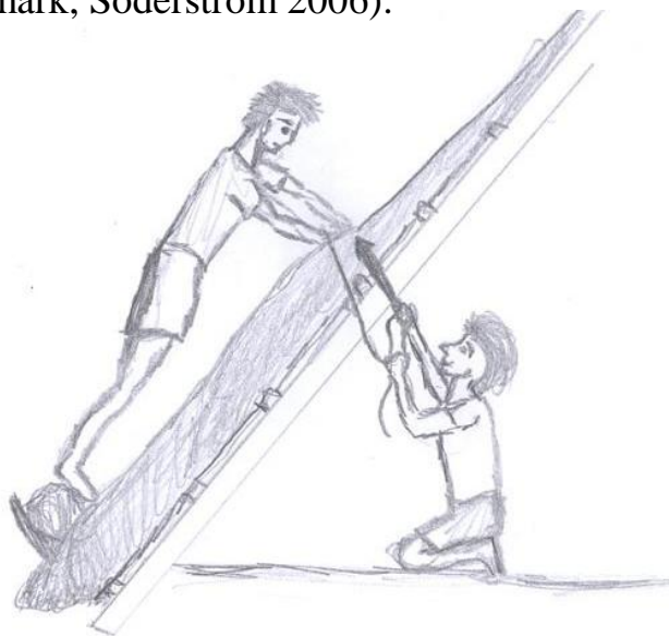
Figur 3: Här sys stråna fast av två hantverkare. Den som står utanpå taket använder sig av en nål och en på insidan hjälper till att sticka ut den igen. (Nilsson och Svensson, 1990).
