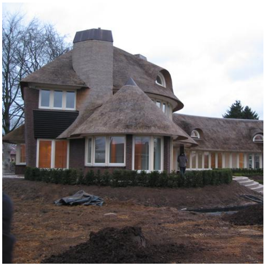
Figur 14: Nybygge med vasstak i Holland (byggnadshantverk, 2012).
