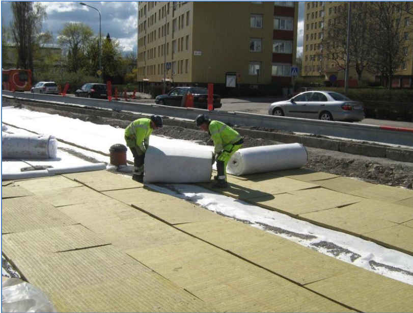
Figur 24: Utläggning av RockDelta stomljudsisoleringsmatta. Källa: Petter Hedin (2012).
