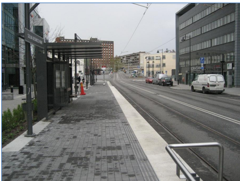
Figur 18: Asfaltsbeläggning vid Solna Business Park. Källa: Mats Fredriksson (2012).
