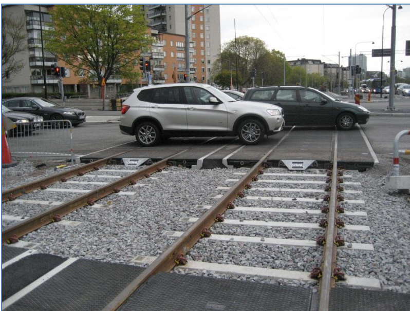
Figur 13: Exempel på hårdgummibeläggning av typ Strails. Källa: Mats Fredriksson (2012).
