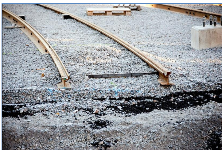
Figur 10: Spårbyggnad med "Göteborgsmetoden" på Tvärbanan. Källa: Thomas Johansson (2012).
