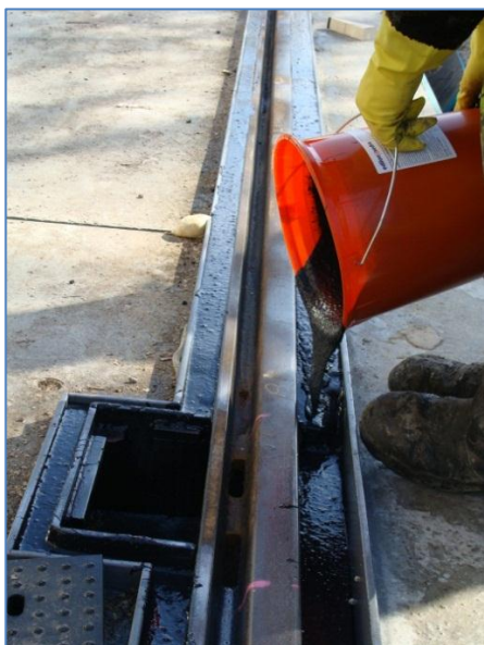
Figur 12: Utrymmet mellan räl och betong fylls med en korkmassa. Källa: Edilon-Sedra (2012).
