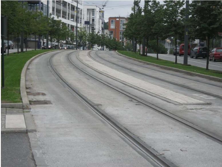
Figur 22: Exempel på ytbeläggning av betong. Källa: Mats Fredriksson (2012).
