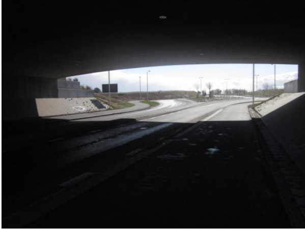
Figur 4.5- Lund Råby tunnel under motorvägen upplevs som otrygg.
