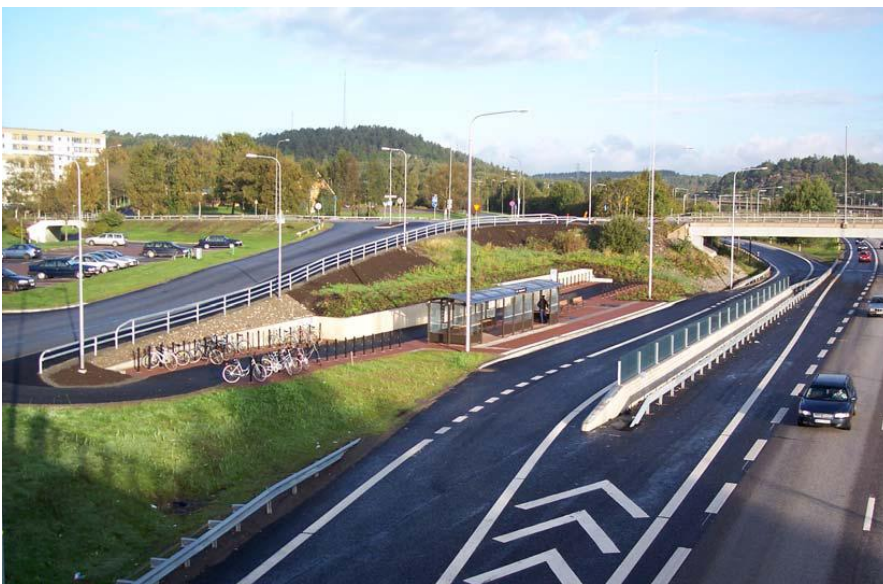
Figur 2.10 - Fall Kungälv där man tar upp stora nivåskillnader med hjälp av ramper för att öka tillgängligheten (Lindeberg & Johansson, 2008).
