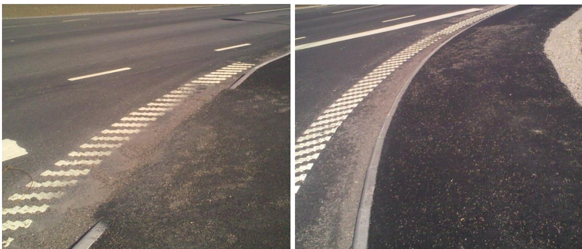
Figur 4.8 - Bilden till vänster är rampen i Skergie där man fasat ner kanten för att möjliggöra övergång för funktionsnedsatta till andra hållplatsen. Bilden till höger är rampen i Håslöv där denna passage är omöjlig för rullstolsburna.
