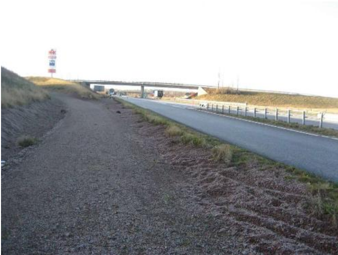
Figur 2.5 - Frånvaro av skiljestaket och räcke ut mot motorvägen (Hammarström, et al., 2010)
