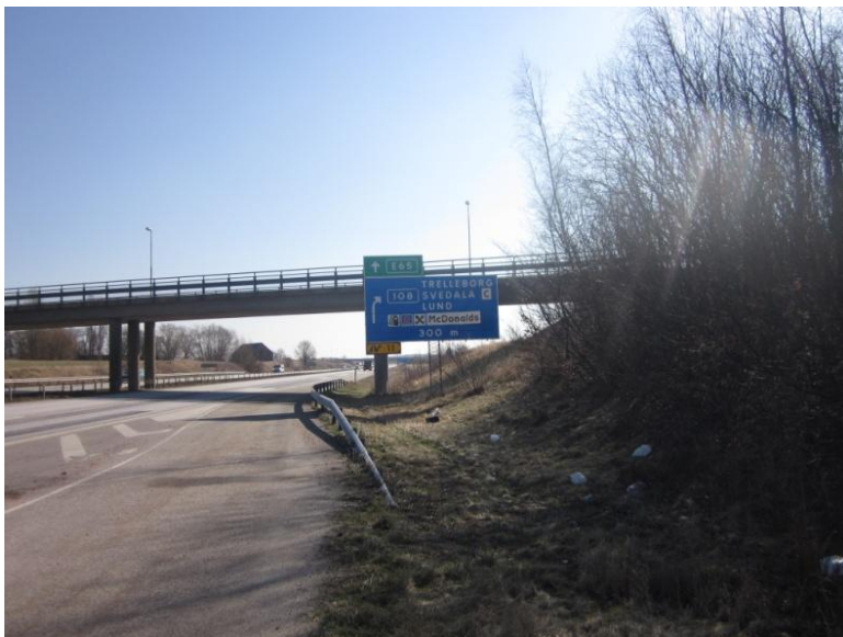
Figur 4.1 - Den vilseledande skyltningen vid hållplats Svedala
