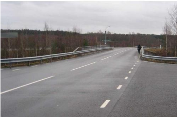
Figur 2.6- Passagen mellan hållplatslägena som leder in till Eket (Hammarström, et al., 2010).
