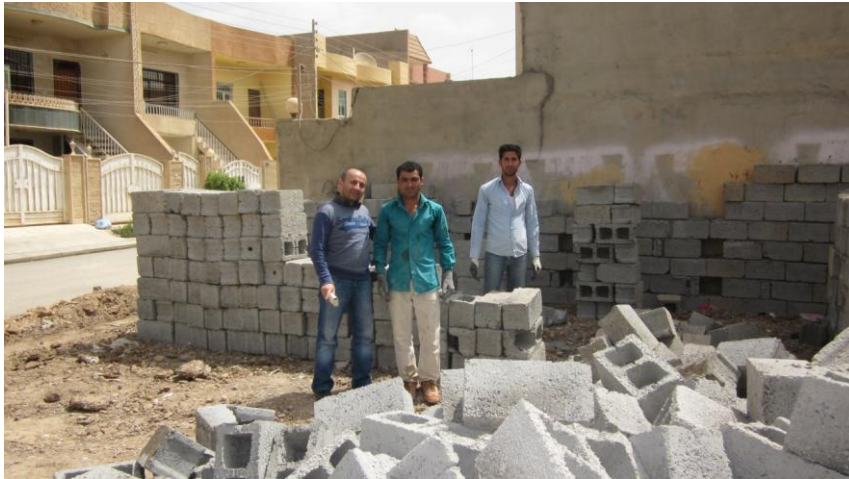
Figur 7.22 Lagring av betonghålblock på arbetsplatsen
