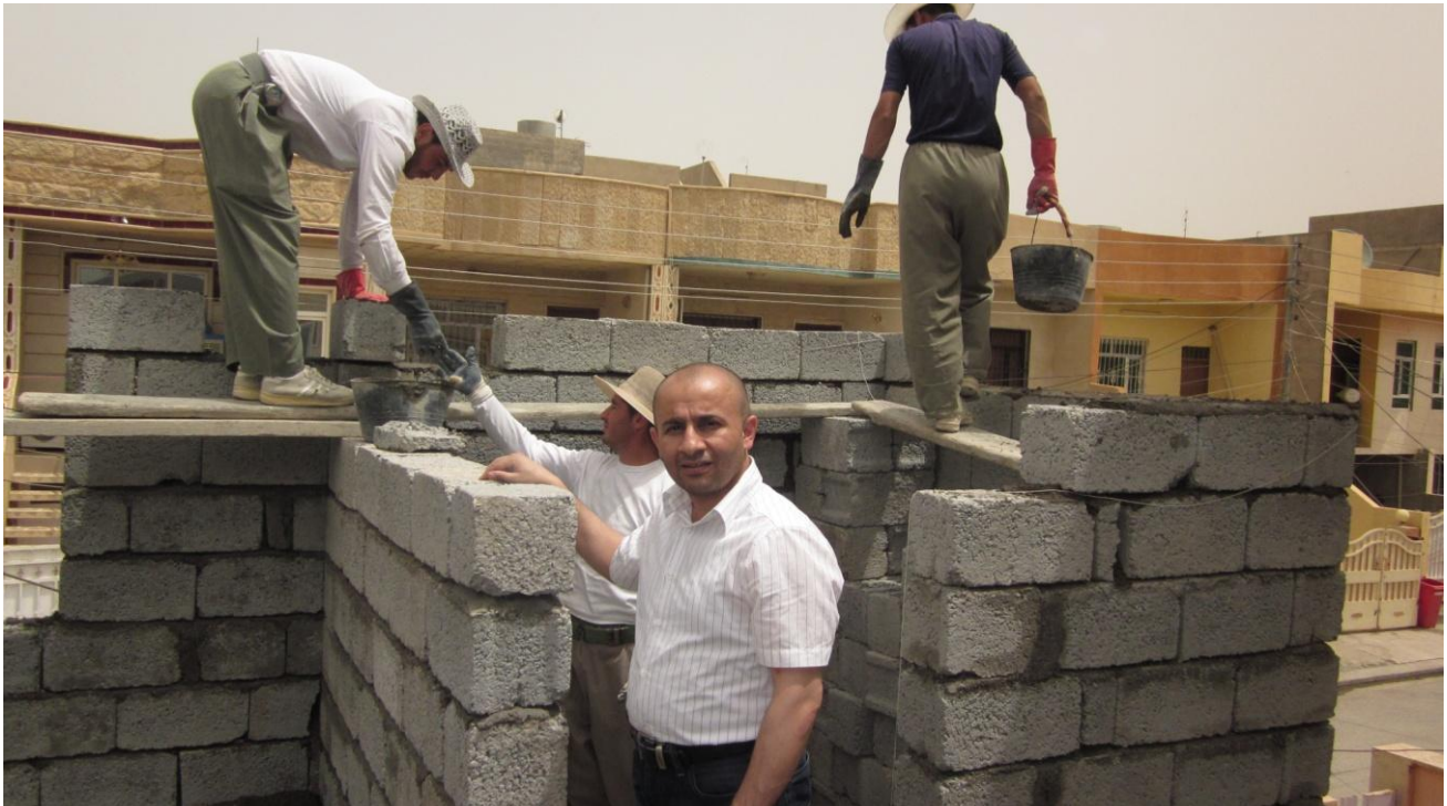
Figur 4.2 Murning av väggar på andra våningen
