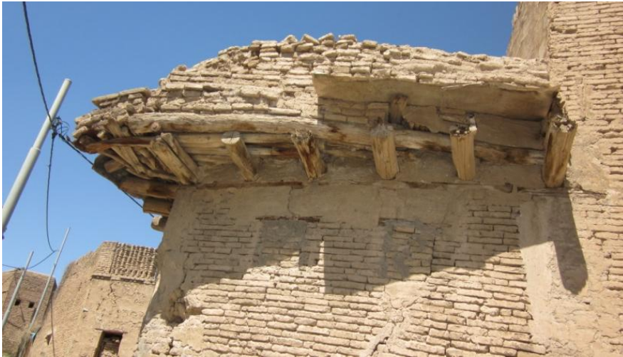
Figur 2.3 En byggnad som består av lera och tegel (Erbil)
