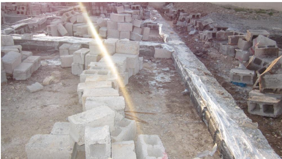
Figur 7.24 Betongblocksgrund i ett större projekt
