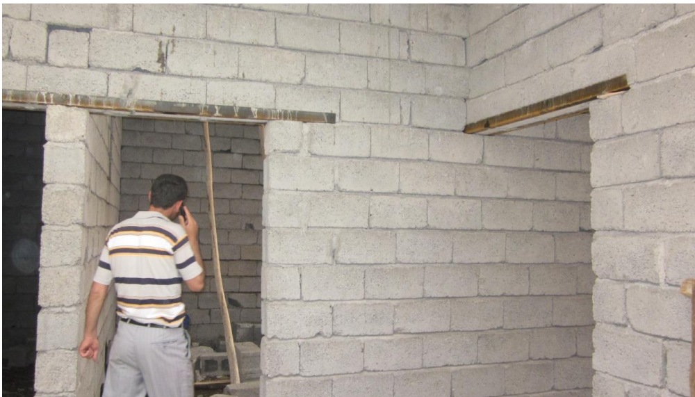
Figur 7.31 Stålbalkar ovanför dörröppningar
