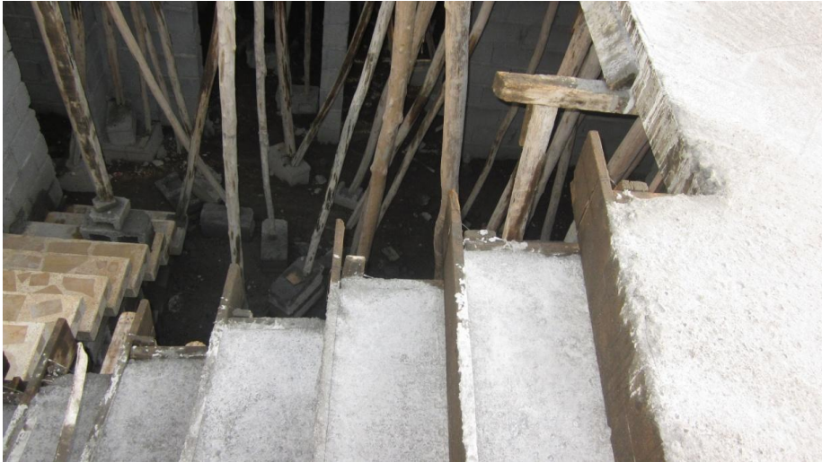
Figur 7.36 Formning och gjutning av trappa
