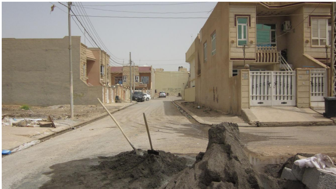
Figur 4.1 Avståndet mellan husfasaden och vägen ska vara minst 5 meter, Avståndet mellan gavel och vägen ska vara minst 1.2 meter.
