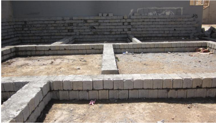
Figur 7.21 Betongblocksgrund
