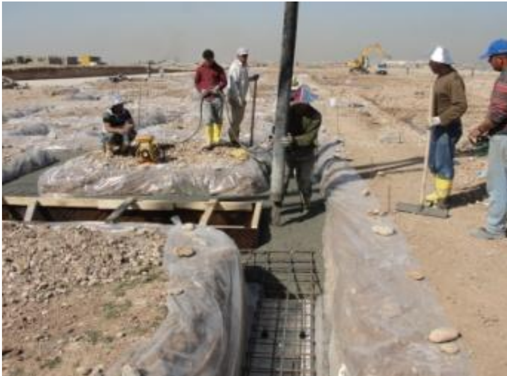
Figur 7.19 Gjutning av grundbalkar efter schaktning
