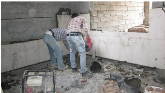
Figur 7.40 Kakelsättning på väggarna
