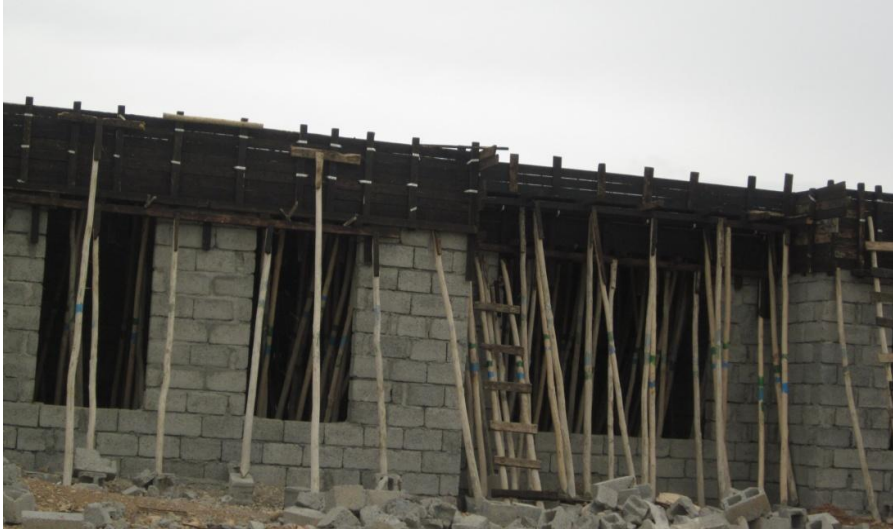
Figur 7.30 Form för gjutning av betong
