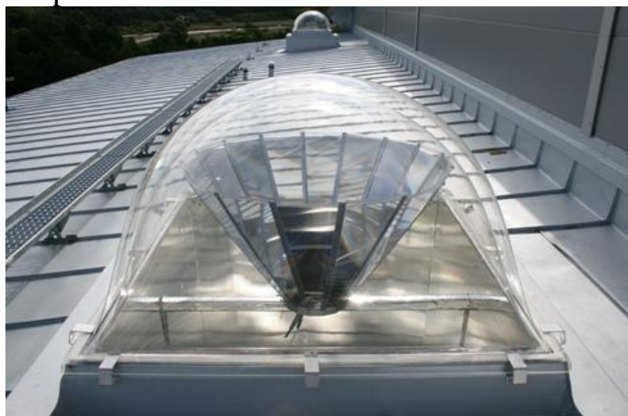
Figur 7. I bilden visas konen med dess 16 prismaskivor placerade i olika riktningar, samt den glaskupol som skyddar konstruktionen.
