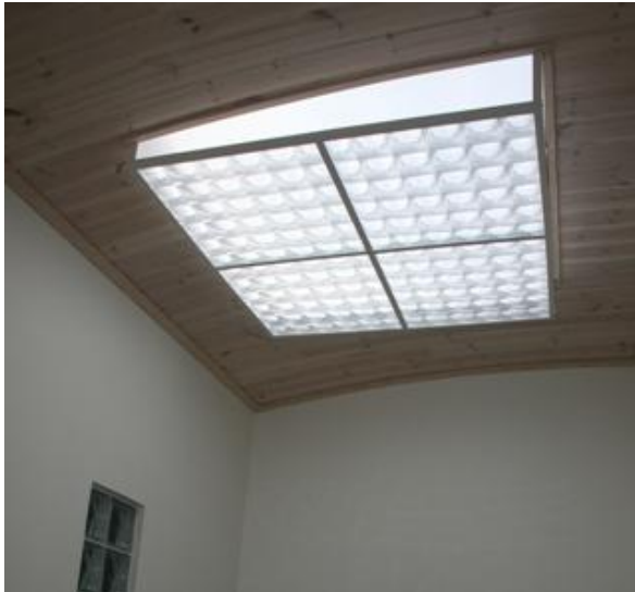
Figur 8. I bilden visas diffusorn vilken är placerad i slutet av ljuskanalen, på insidan av taket.
