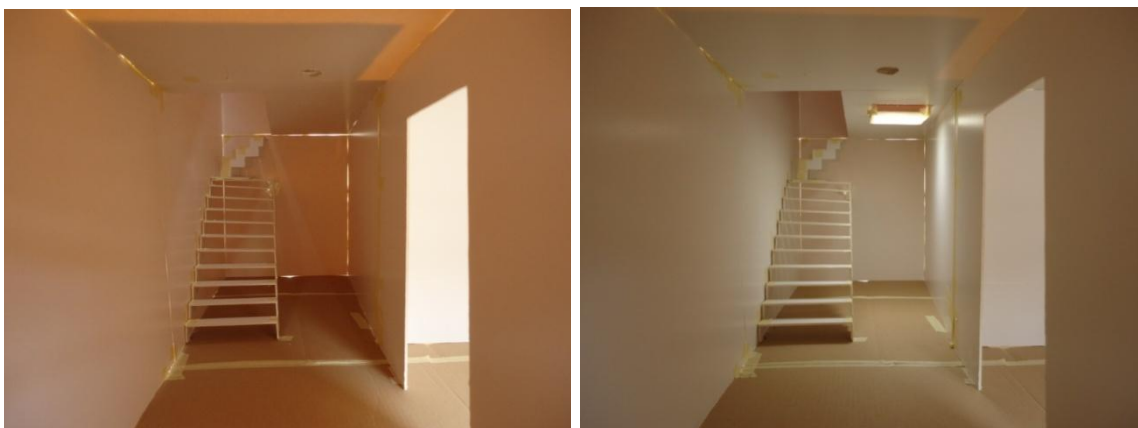
Figur 13. Originalhuset (till vänster) jämförs med schakt bredvid trappan (till höger).
