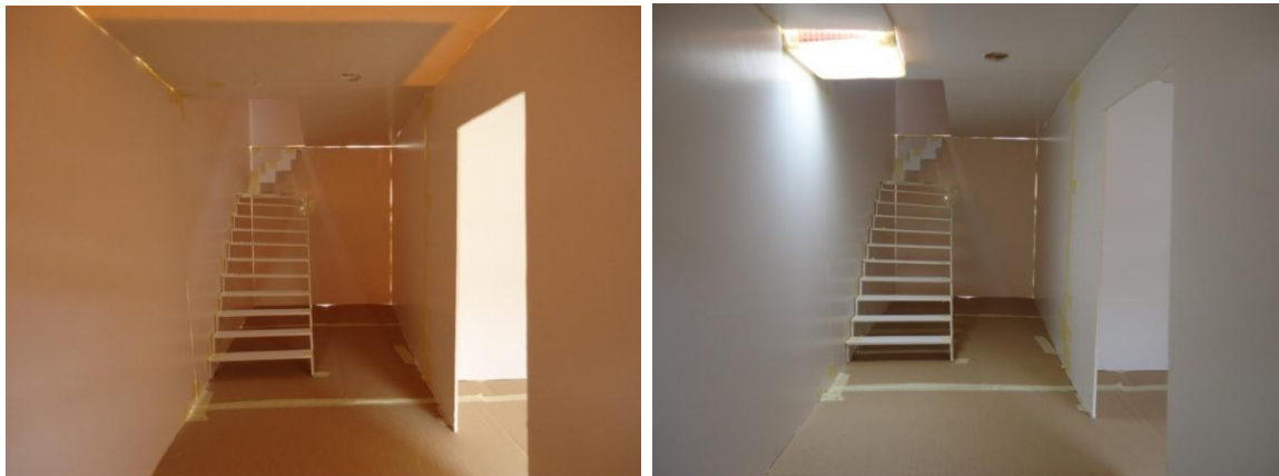
Figur 15. Originalhuset (till vänster) jämförs med schakt nedanför trappan (till höger).
