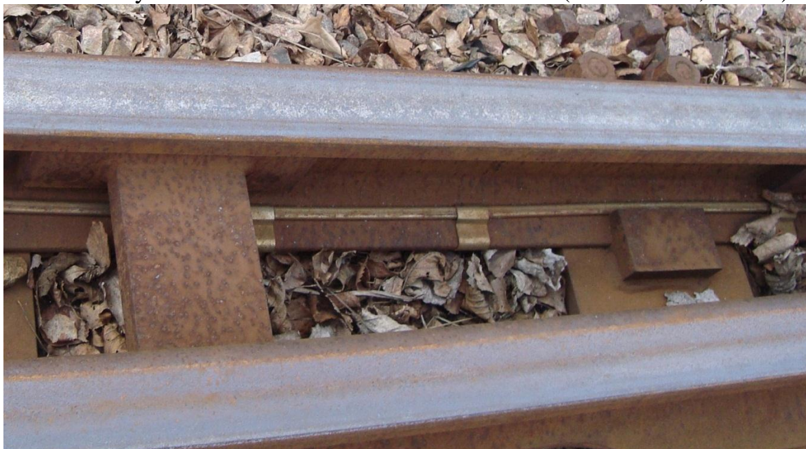
Figur 1 Standardmonterat växelvärmeelement fastsatt med fjäderklamrar
