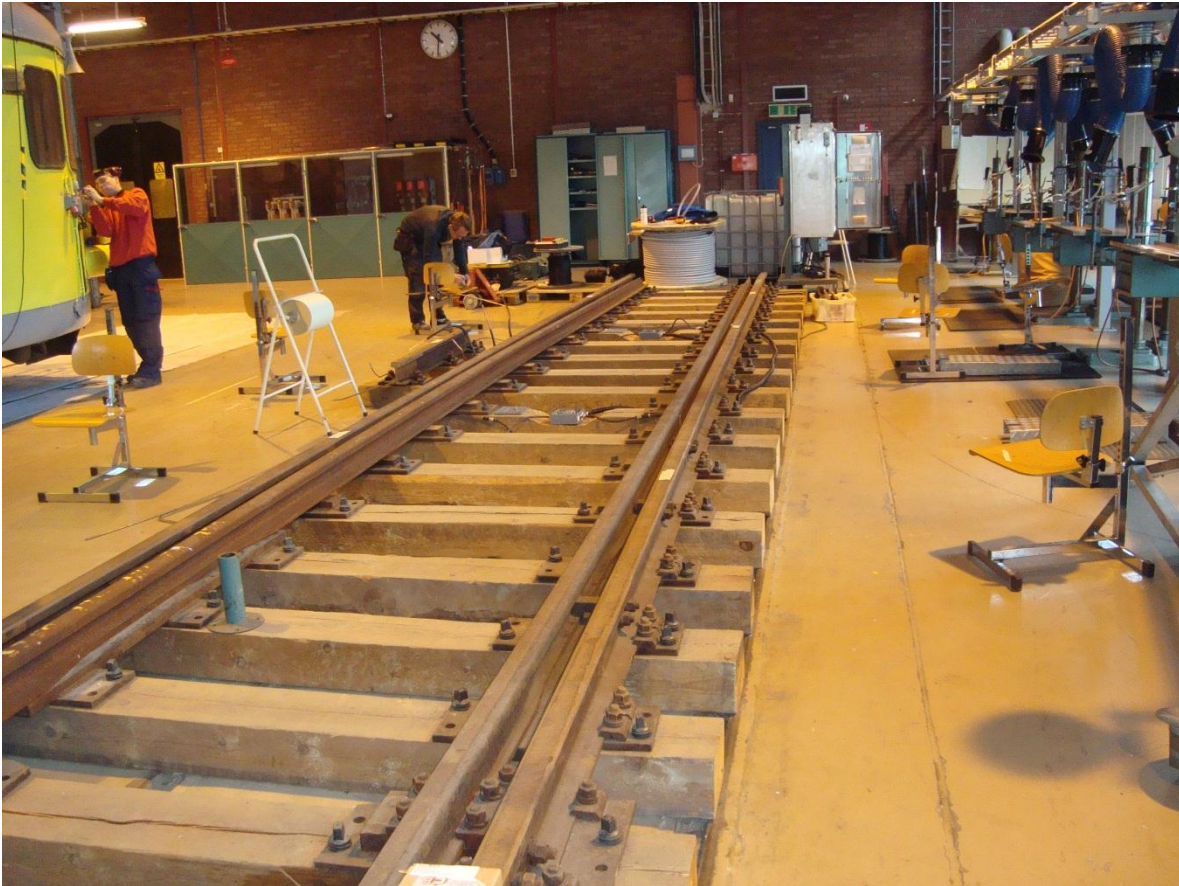
Figur 6 Spårväxeln redo för mätning, mätpunktsstolar utplacerade.
