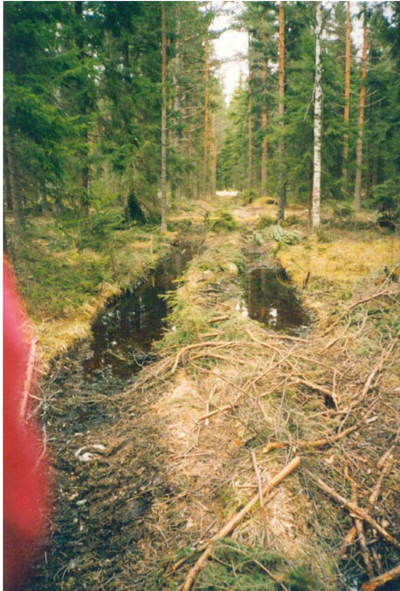
Appendix 1: Bilden visar en av de stickvägar (basvägar) som finns i området och dess påverkan genom körskador. Bild tagen av Fredrik Lagergren, används med tillåtelse.
