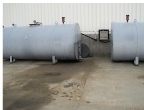
Figur 8: Cisterner med motorolja och växelolja utanför verkstaden på den södra sidan av fastigheten. Oljeläckage har skett från cisternerna. (Foto: Helena Ensegård).
