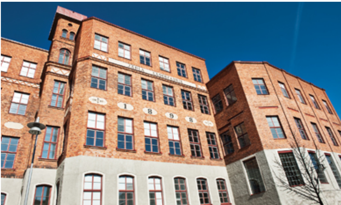
Figur 8: Nya bostäder i Järla sjöns gamla industribyggnader (Bäckman, 2011)
