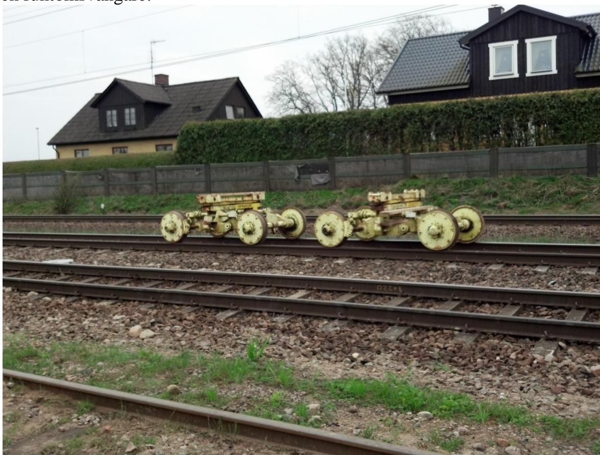
Bild 12: Trallorna som transporterar växel 31 a till den norra änden
