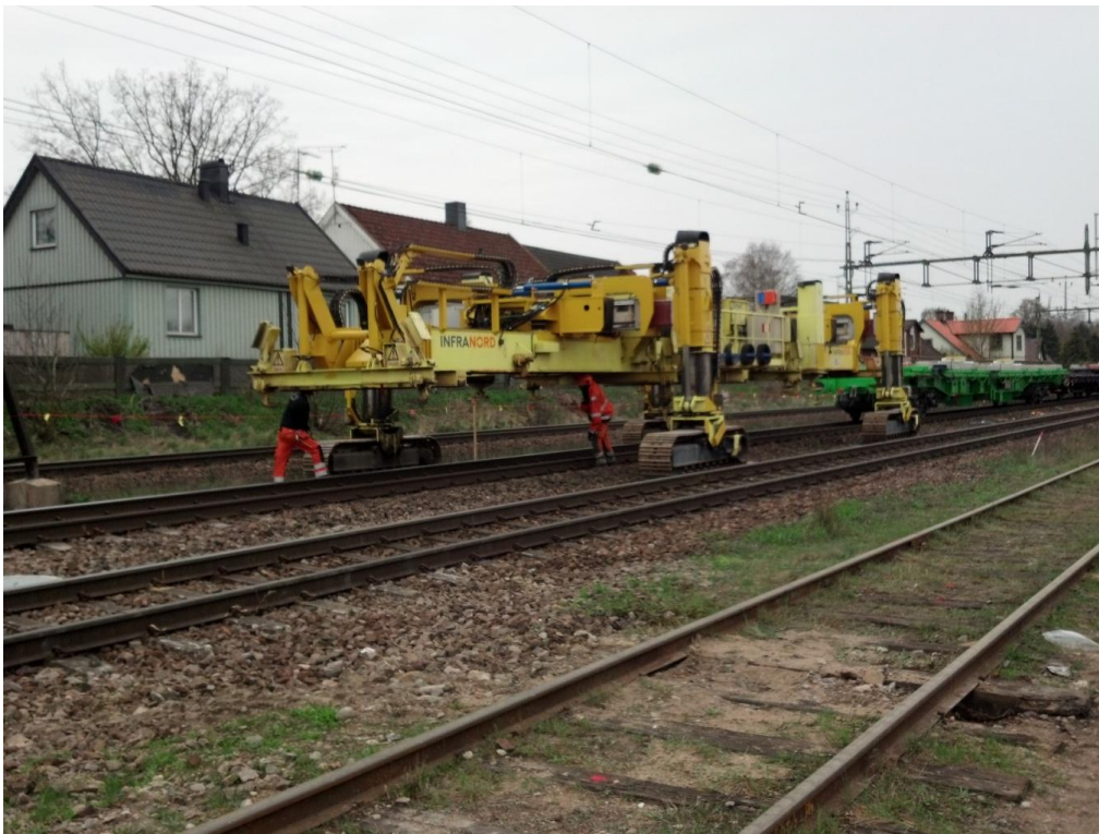
Bild 5: Desec under arbete
