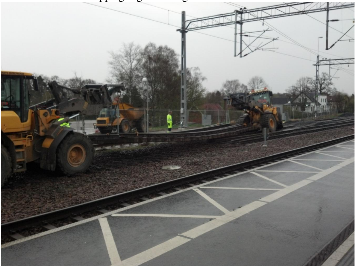
Bild 11: 2 hjullastare som samverkar vid växel urtagning
