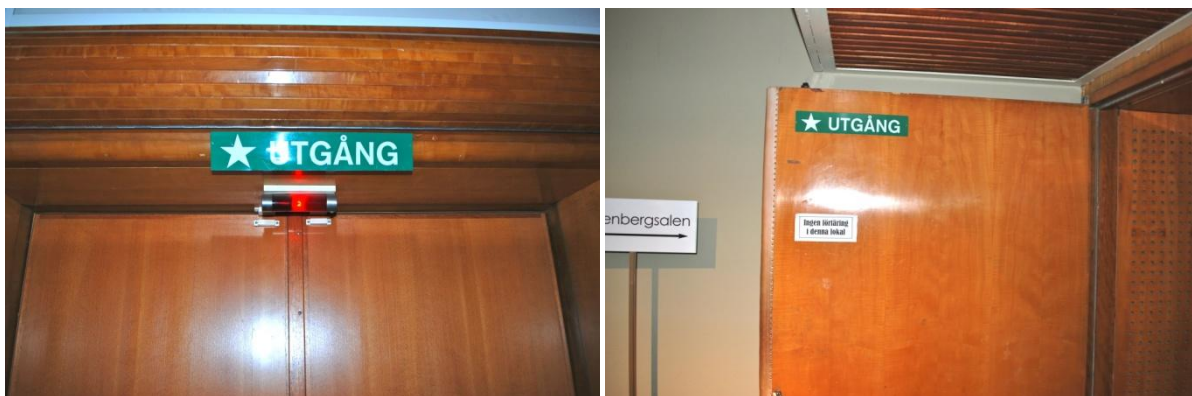
Figur 3.6 Icke genomlysta utrymningsskyltar.
