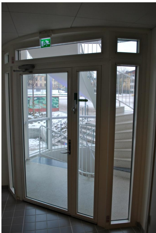
Figur 3.10 Dörr som inte är öppningsbar från trapphuset.
