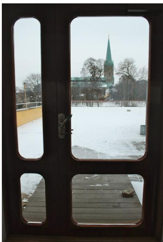
Figur 3.5. Nödvred används uteslutande i utrymningsvägarna som leder till det fria.
