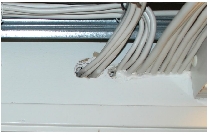
Figur 3.9 Otillräckliga tätningar i fläktrummet mittemot måleriet.
