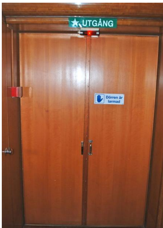
Figur 3.4. Vanligt vred används normalt i utrymningsvägarna som inte leder till det fria.
