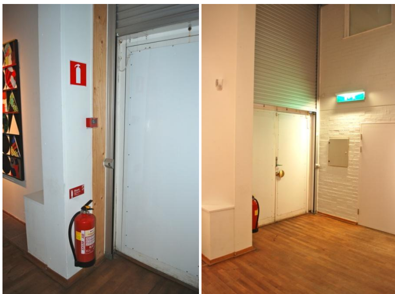
Figur 3.7 Placering av brandsläckaren i utställningssalen.
