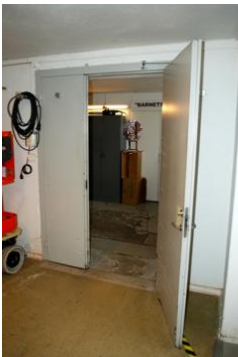
Figur 3.8 Dörr i källaren vars dörrstängare inte fungerar.
