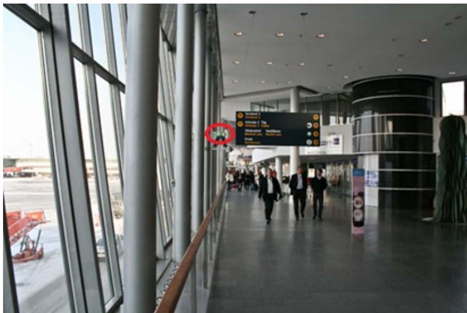
Figur 5.2. Ytterligare exempel på svårupptäckt utrymningsskylt.
