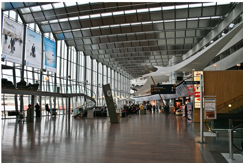
Figur 5.1. Svårupptäckt utrymningsskylt (markerad).
