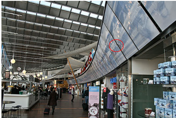
Figur 4.1. Sprinkler ovanför butiker, vinklade mot Plazan.
