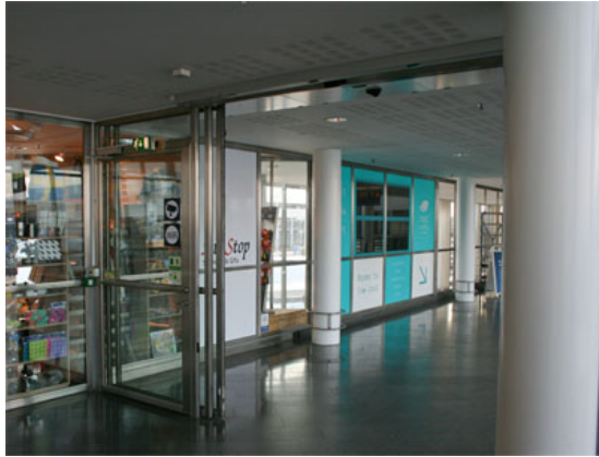
Figur 4.3. Utrymningsväg mot terminal 4.
