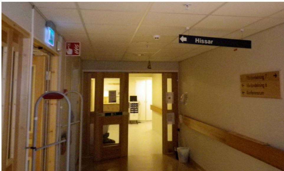
Figur 3.1. Dörr i utrymningsväg.
