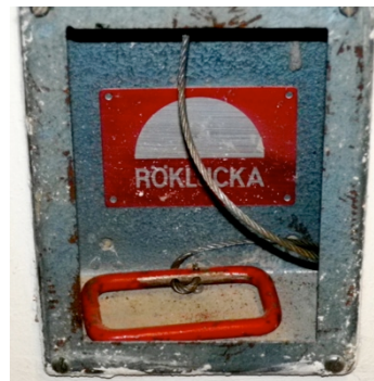
Figur 2.12. Handtag för öppning av röklucka.
