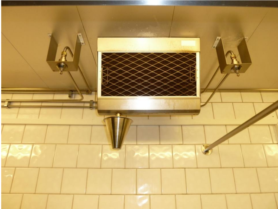
Bild 2.10. Dysor (till höger och vänster om fläkten) för kökets släcksystem.
