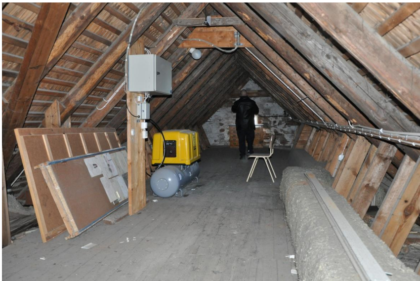
Figur 9. Del av vind med VMA-utrustning.
