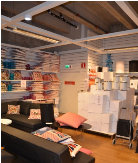
Foto 7.1 Blockerad nödutgång på nedre plan i Chilli.
