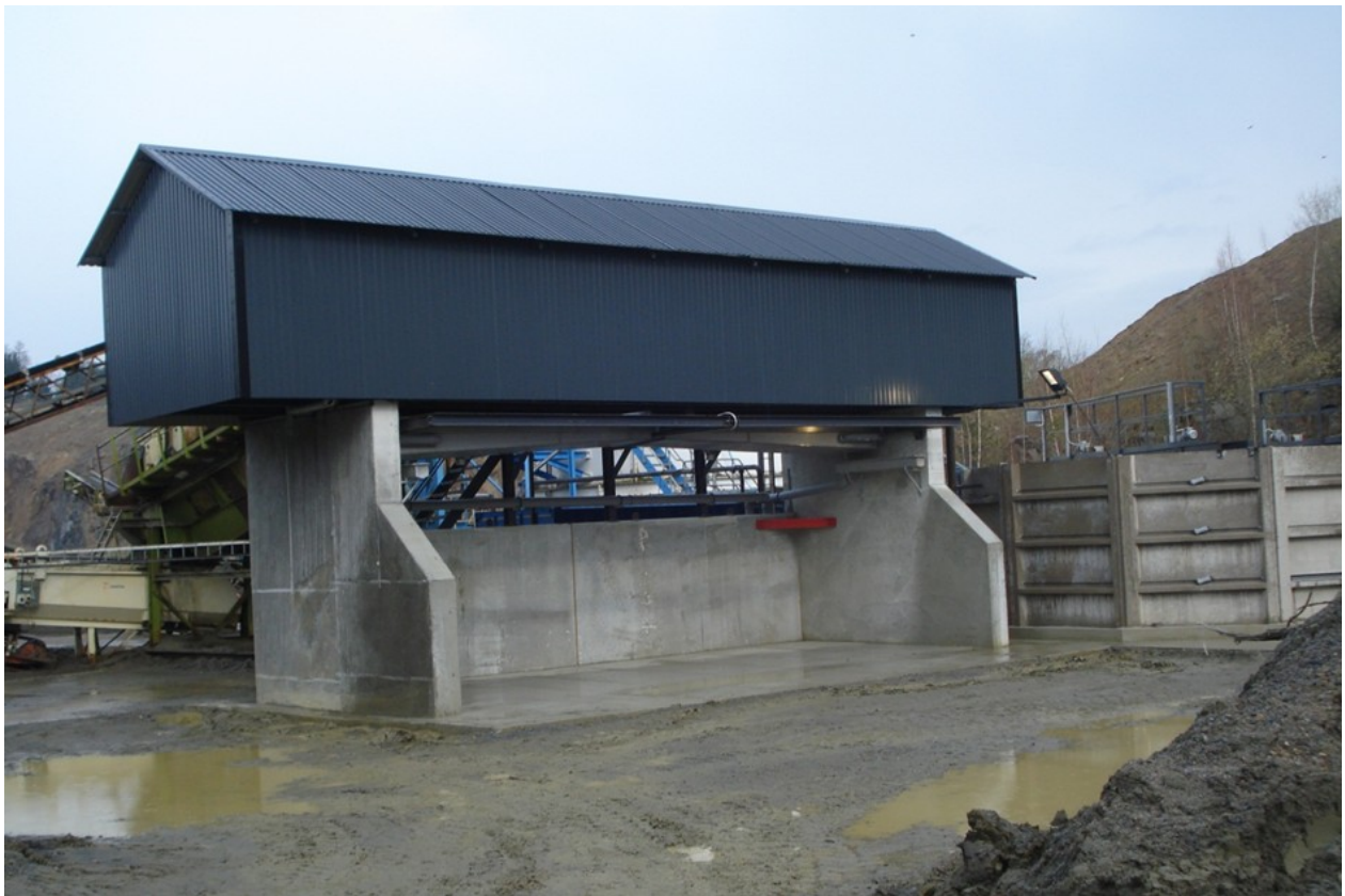
”Figur 13 filterpressen bakifrån. Bilden visar där sista steget i processen. När processen är i gång så kommer finfraktionerna att falla ner här. Bild Fredrik Nylén”
