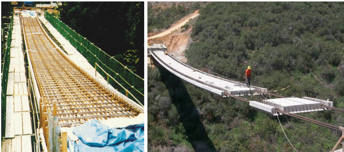
Figur 3.1 Till vänster visas ett fotografi av Birdie Bridge i Ibaraki Prefecture, Japan. Bron byggdes med platsgjutningsmetoden ( www.acc-club.jp ).
