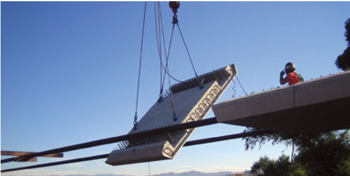
Figur 3.2 Placering av prefabricerade betongelement vid bygget av Lake Hodges Bicycle Pedestrian Bridge, San Diego, USA. Den längsta stress ribbon bron i världen år 2009, med tre spann på ca 100 m vardera ( www.gostructural.com ).
