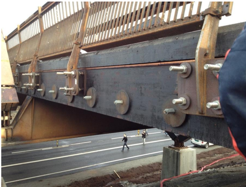
Figur 27, Bågbro i trä med körbanan av tvärsända lameller med modernt förankringssystem, belägen i Norge
