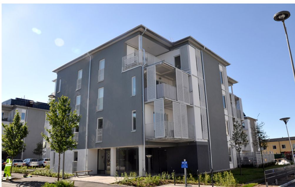
Figur 5.1 - Beckomberga med smala fönster och justerbar solavskärmning kring balkongerna.
