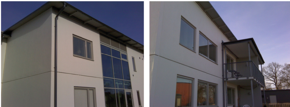
Figur 5.2 - Björka hustyp A, med sin glasade entré och fristående balkongkonstruktion. Foto: Danebjer, Ekström, 2012.
