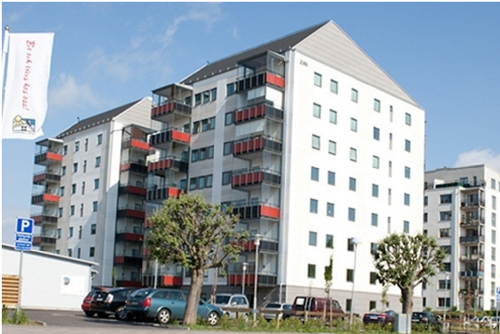
Figur 5.4 - Portvakten med sina utanpåliggande balkonger. Notera bottenplanet i betong och sadeltaket som är vinklat för solfångarmontage.
