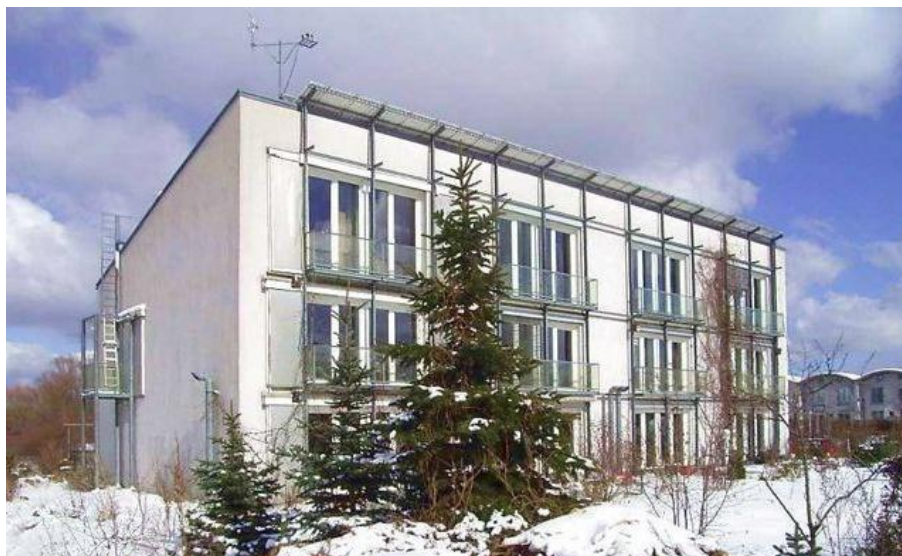
Bild 1; Det första passivhuset, Darmstadt Tyskland. Källa: http://www.passiv.de , (2009-04-20)
