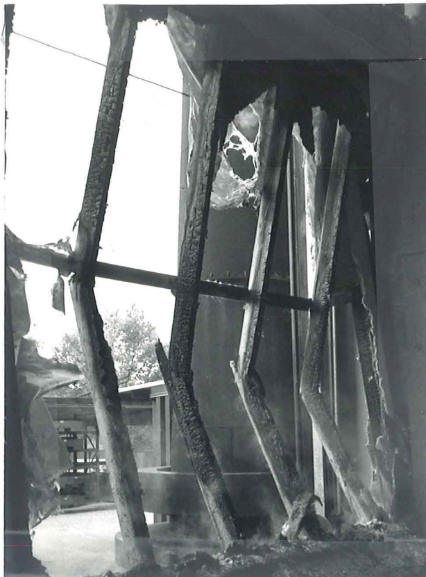
Fig. 50: Provväggen efter det att försöket avslutats och branden släckts. Notera förkolningen och hur samtliga regler har knäckt i styva riktningen.
