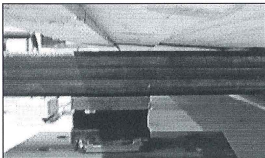
Figur 6.16, Bjälklaget har vissa skevheter vid upplagen, vilket medför att bjälklaget inte vilar plant mot stöden.
