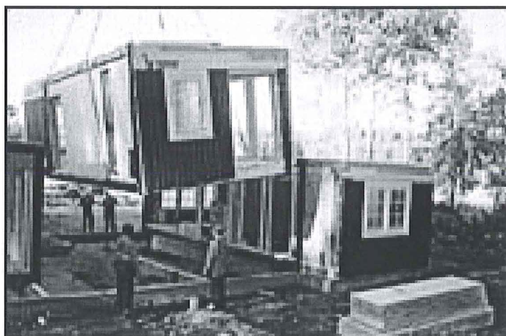
Figur 48. Montering av Modulentvilla, [35].
