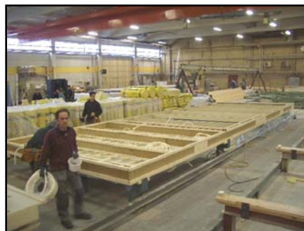
Figur 2.1 Tillverkning av bjälklag
