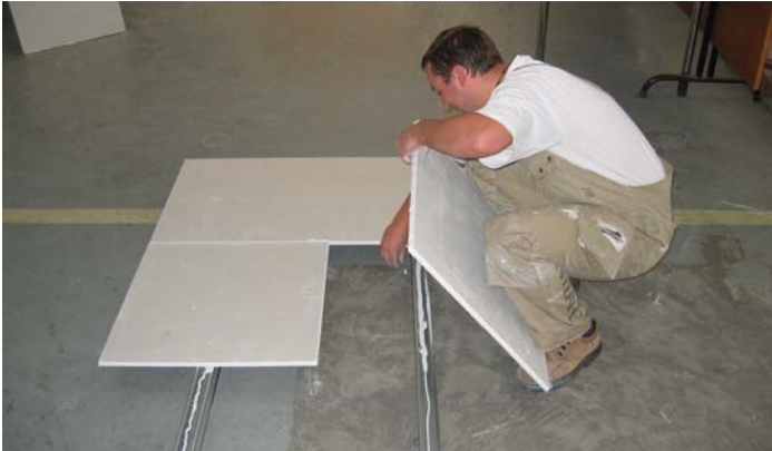
Figur 8 Montage spontvägg
