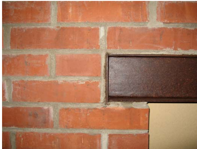
Figur 4-10. Stående VKR-stålprofil med plattstänger. Tre stötfogar på höjd.
