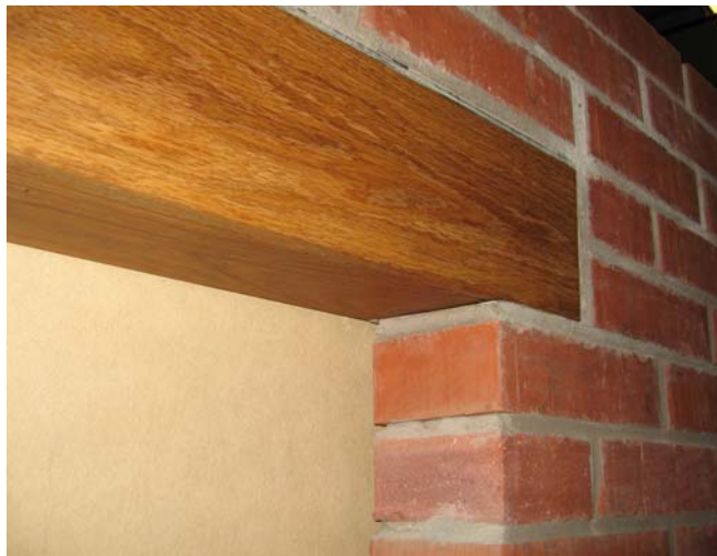
Figur 4-18. Fullskalemodell av UPE-stålprofil med träfront vid upplag.
