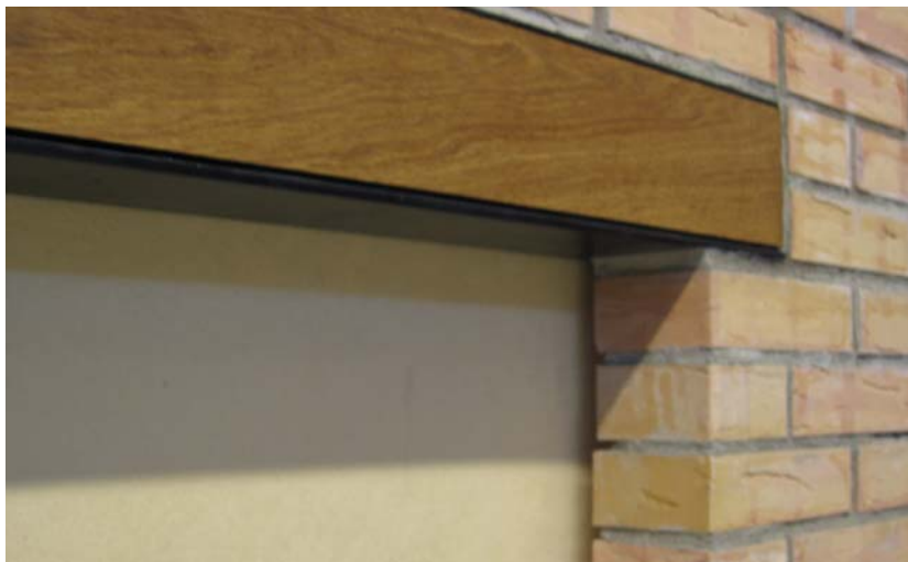
Figur 4-22. Vinkelstång med träbalk vid upplag.
