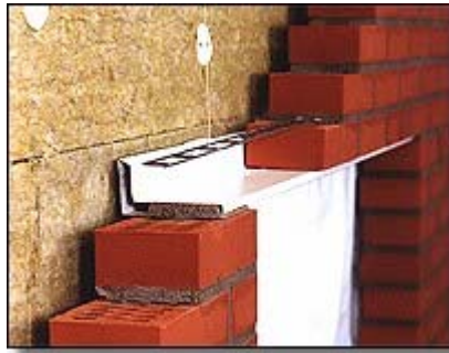
Figur 3-1. Murma väggbalksystem.
