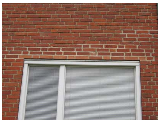
Figur 3-12. Armerad tegelbalk i avvikande kulör och varierande färg och tjocklek på fogarna, Kakelvägen, Lund.
