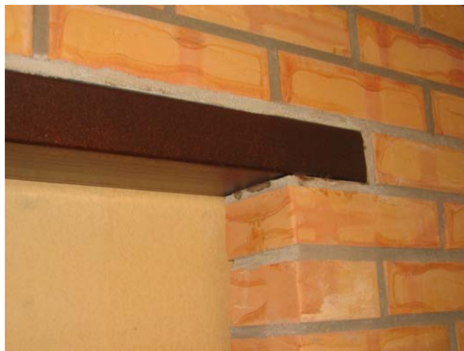
Figur 4-5. Liggande VKR-stålprofil vid upplag. Linolja på liggfogen under upplaget.
