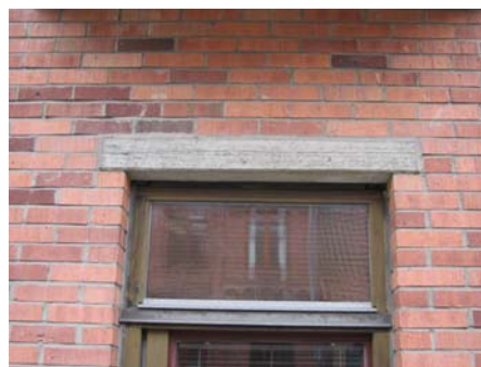
Figur 3-5. Armerad betongbalk från fastighet på Bredgatan i Lund.
