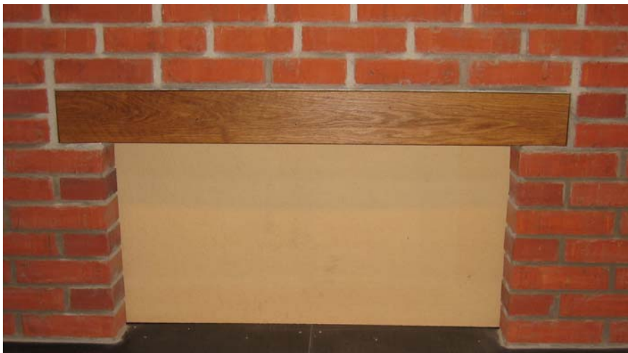
Figur 4-17. Fullskalemodell av UPE-stålprofil med träfront.
