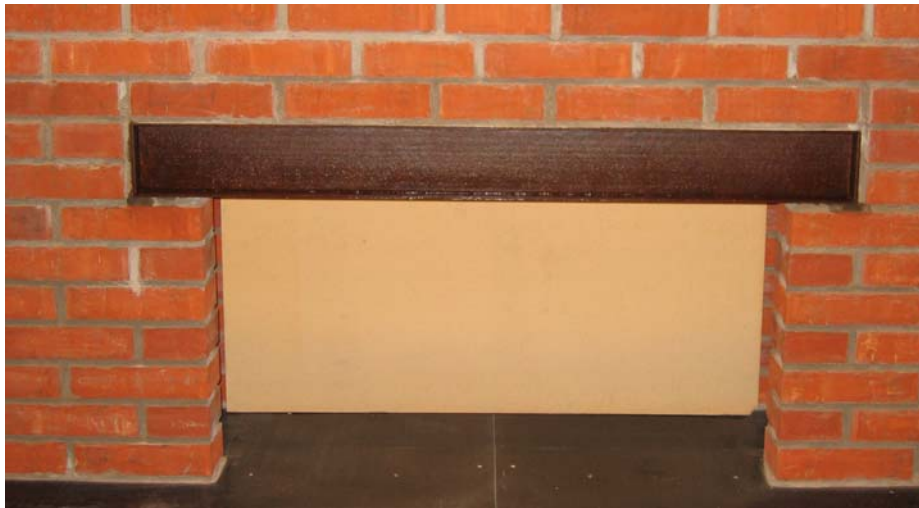
Figur 4-8. Fullskalemodell av stående VKR-stålprofil med plattstänger.
