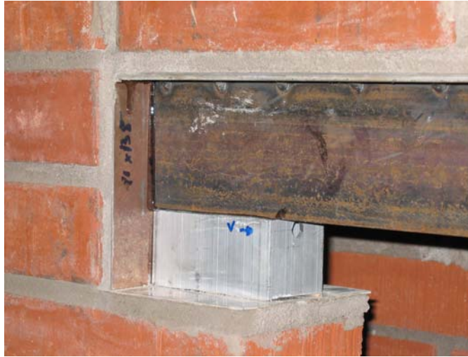
Figur 4-15. Stålkonstruktionen monterad och inmurad i fullskalemodellen. Träkonstruktionen monteras senare.
