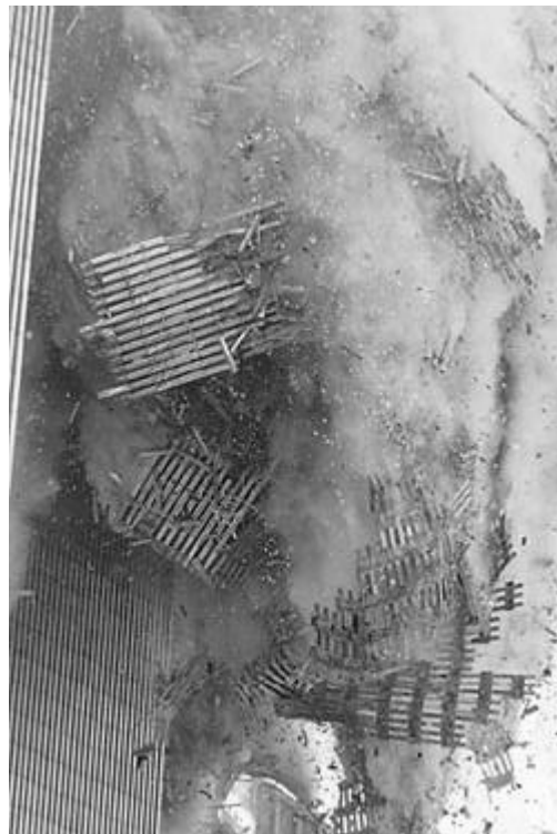
Figur 2.3 Kollapsen av World Trade Center [4]
