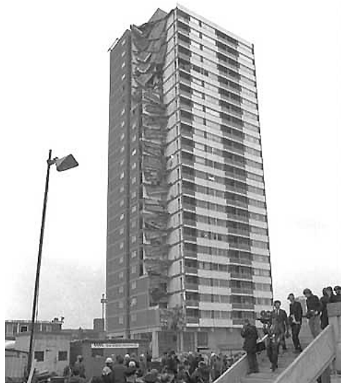
Figur 2.1 Hushörnet på huset i Ronan Point rasade som följd av en gasexplosion på 18:e våningen [2]
