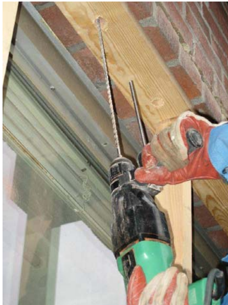
Figur 31. Förborring för skruv.
