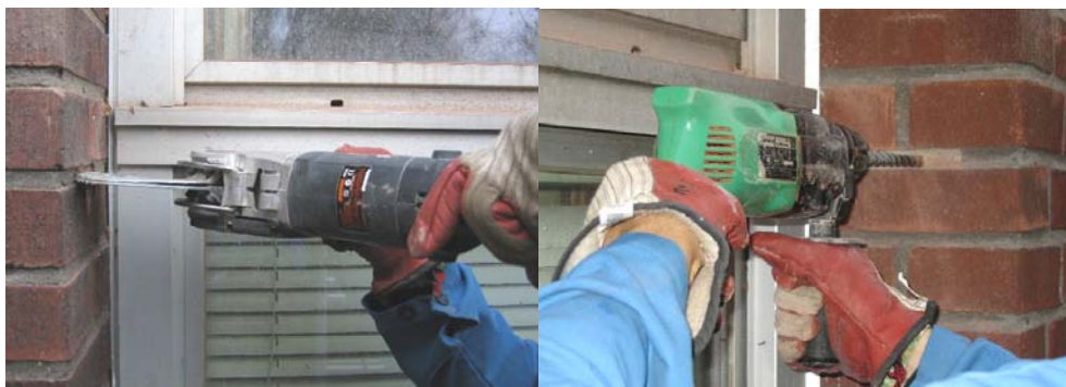
Figur 27a och 27b. Fogfräsning och förborring för att installera fogbräcka.
