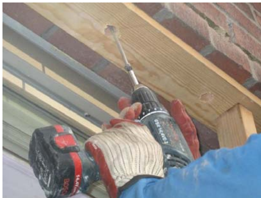
Figur 34. Installering av skruv.
