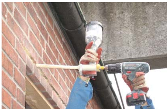
Figur 38. Fogning med fogspruta.
