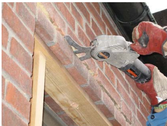
Figur 35. Fräsning av liggfog med det breda bladparet.
