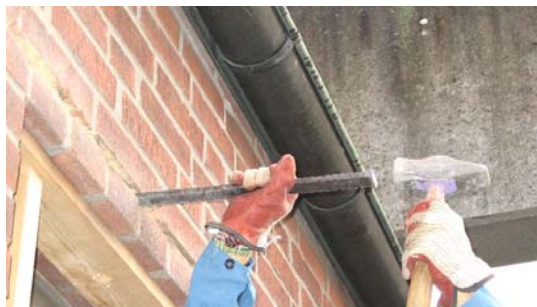
Figur 37. Användning av stämjärn.
