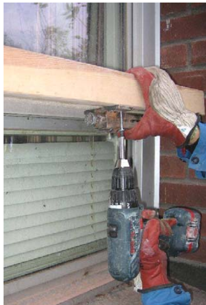
Figur 30. Installering av den skruvlimmade balken.
