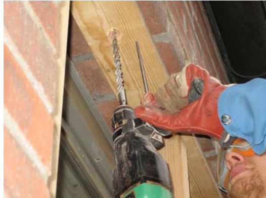
Figur 33. Försänkingsborrning för skruv.
