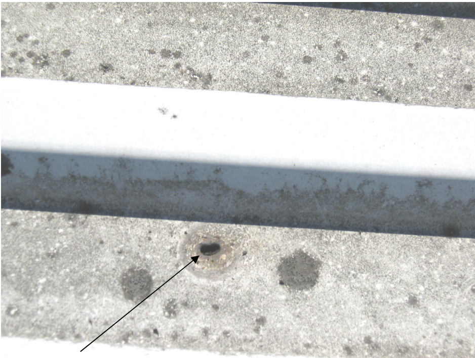
Figur 5.2 Hålkantsbrott
