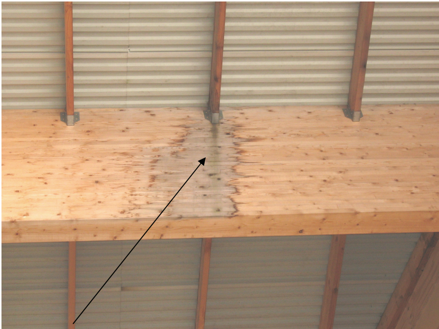
Figur 5.1 Vattenläckage
