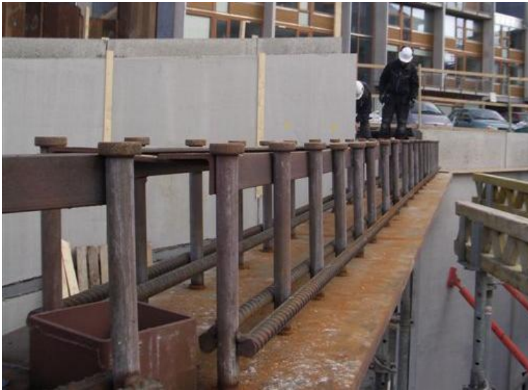
Figur 11. HPC-balk upplagd på HPC-pelare.
