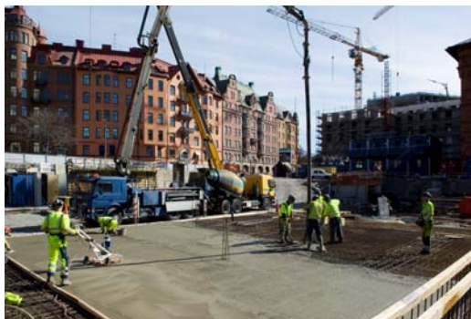
Figur 3.11 Gjutning av bjälklag med pump (Fotograf Daniel Hertzell)
