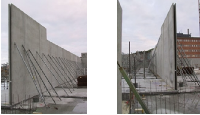
Figur 3.5 Monterade skalväggar (Färdig Betong AB, 2008)
