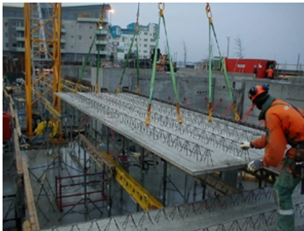
Figur 3.3 Montering av plattbärlag (BetongBanken, 2008)
