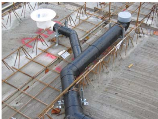
Figur 3.9 Prefabricerad avloppsenhet monterad på plattbärlag
