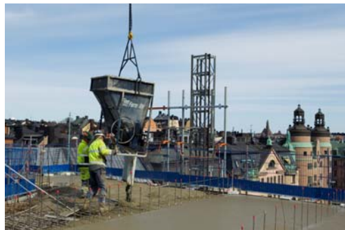
Figur 3.12 Gjutning av bjälklag med kran och bask (Fotograf Daniel Hertzell)
