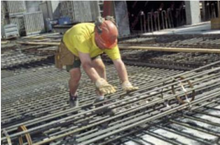
Figur 3.8 Utrullning av rullarmering (Tibnor, 2007)
