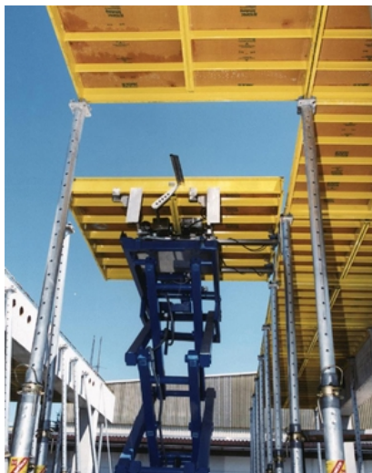
Figur 3.2 Luckform utan bockryggar (s.k. nollbalksystem) (Hünnebeck, 2008)
